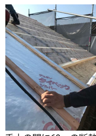
垂木の間に60mmの断熱材を敷き込み遮熱用の透湿防水シートを貼り、通気胴縁を取り付ける
