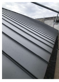
ガルバリウム鋼板を貼る
