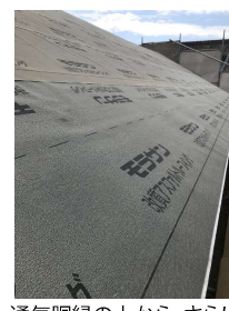
通気胴縁の上から、さらに針葉樹合板を貼り、改質アスファルトルーフィングを貼る
